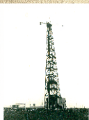
▲ 1975年炼油厂工程打下第一根桩
