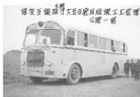
▲ 1958年10月中波（常洪）至锦河公路竣工
