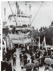
▲ 1978年12月镇海煤炭码头建设工程投产
